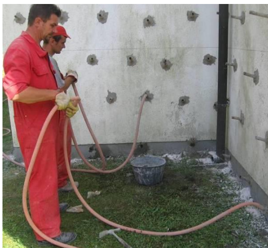
Slika 1.1: Linijsko vbrizgavanje malte [24].
